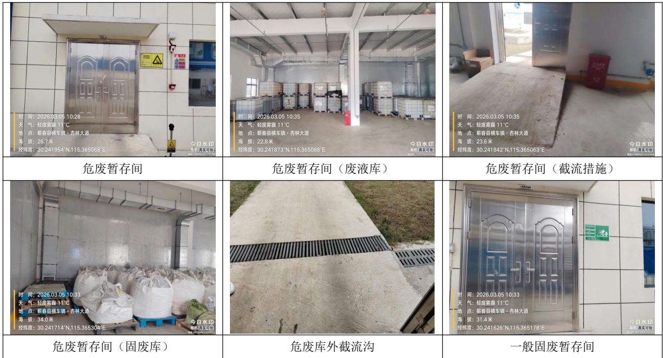
图 4.1-7 项目危废暂存间建设情况图
