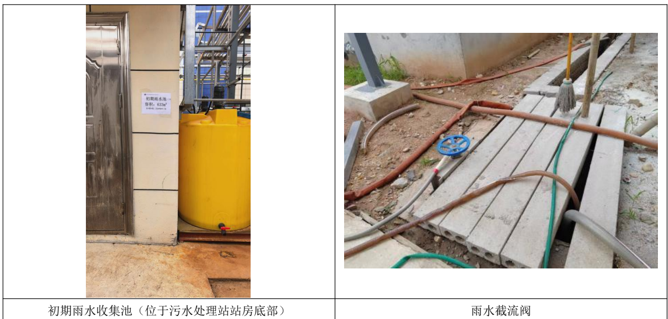
图 4.1-4 项目初期雨水收集系统图
