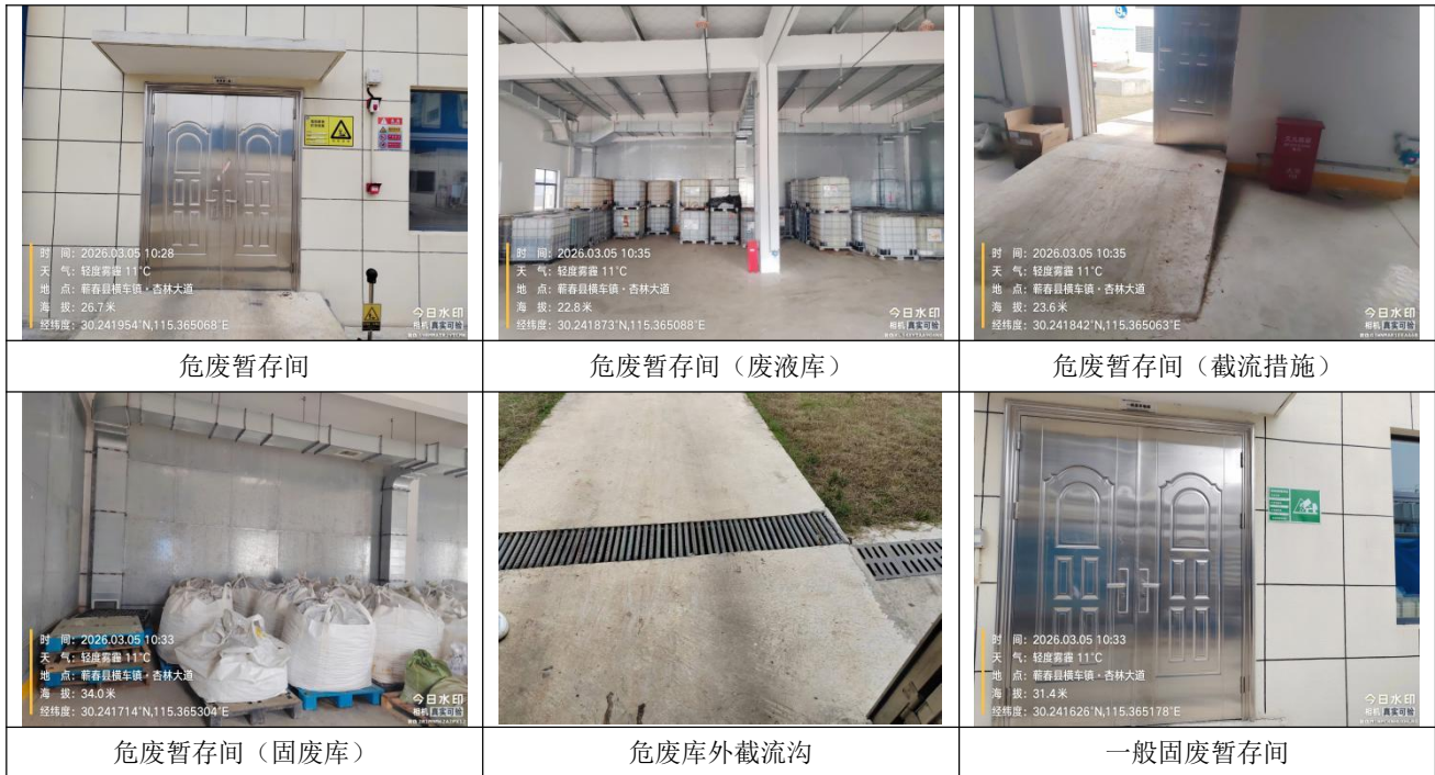
图 4.1-7 项目危废暂存间建设情况图
