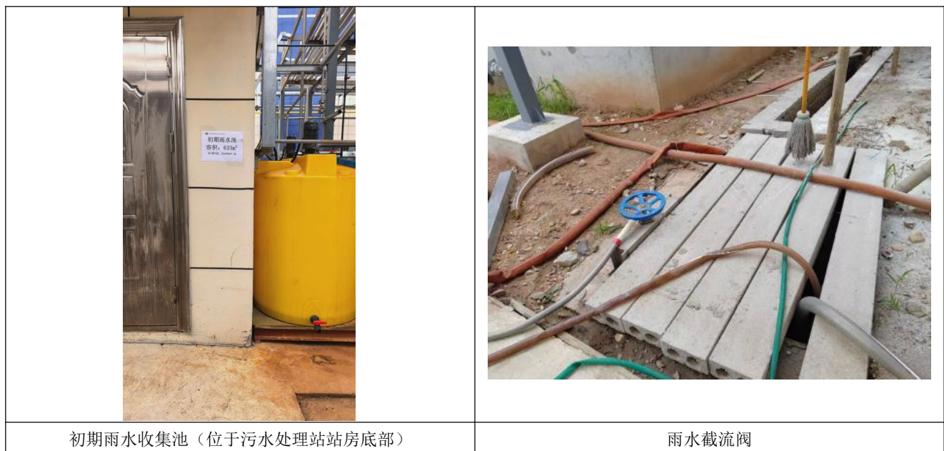
图 4.1-4 项目初期雨水收集系统图
