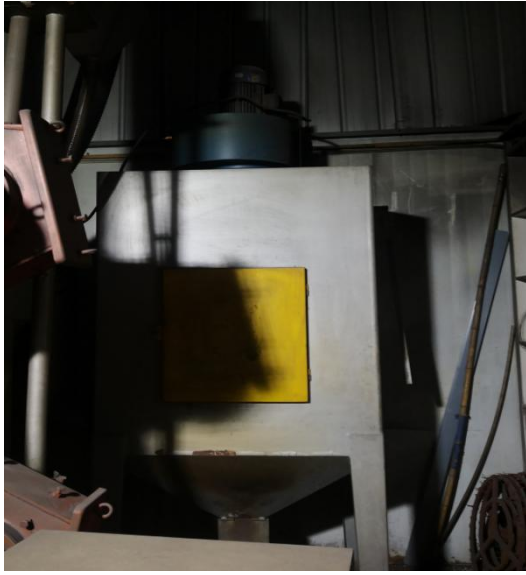
布袋除尘器（喷砂废气）
