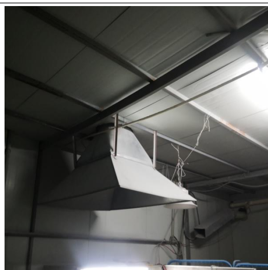
自动喷砂机废气集气罩
