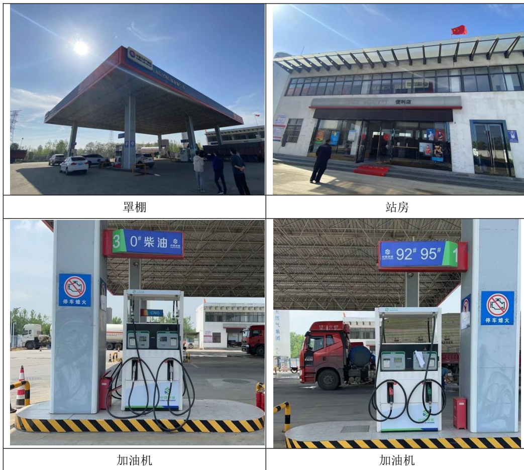
图 2-1 项目现场情况图片
